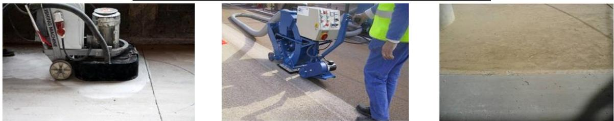
基础混凝土地面打磨、抛丸、吸尘、修补处理
