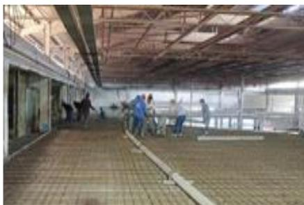
C30 钢纤维混凝土加网片浇筑
