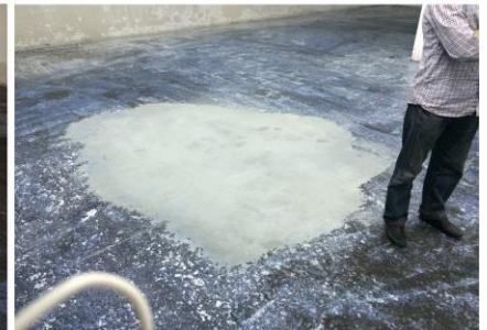
破损地面坑洞修补
