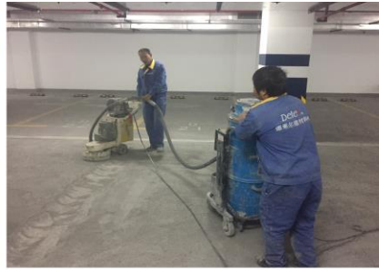
地面整体打磨处理
