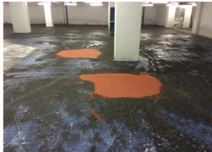
破损地面坑洞修补
