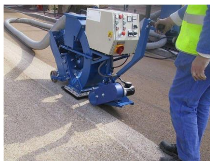
抛丸机地面处理
