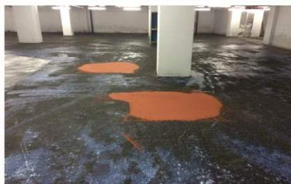
破损地面坑洞修补
