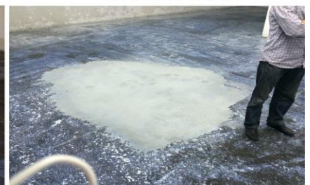
破损地面坑洞修补
