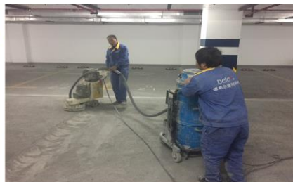
地面整体打磨处理
